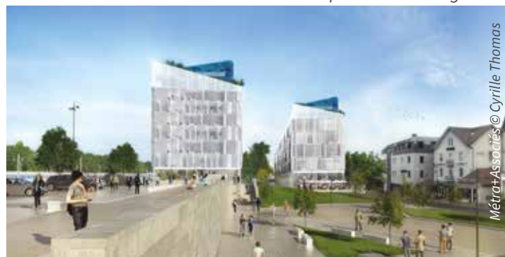
des deux bâtiments «signal»
