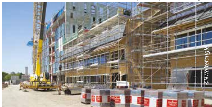
Vue de la construction du bâtiment A1
