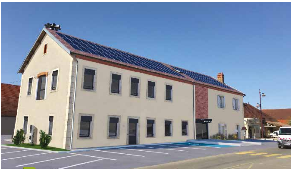
Serge Roux Architecte
